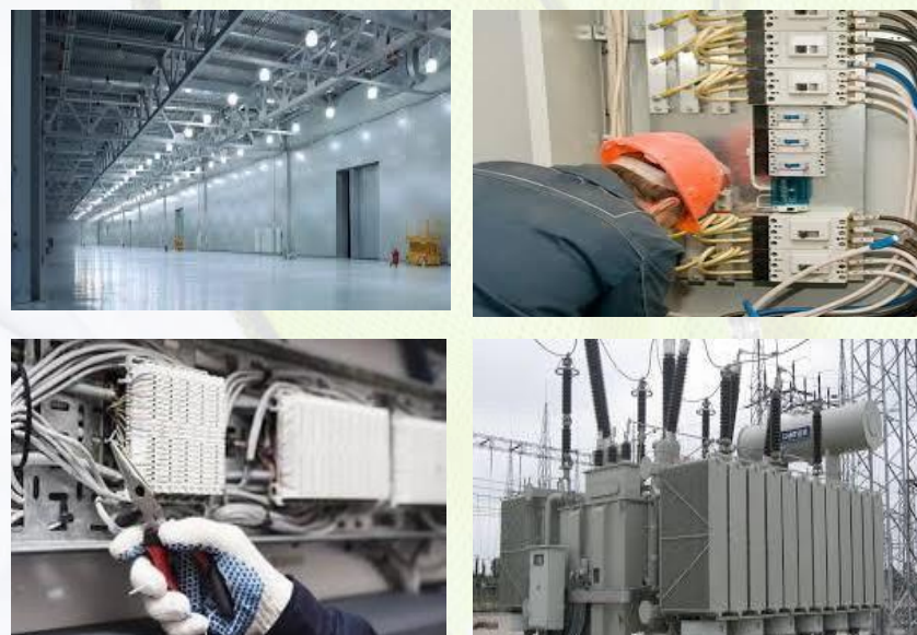
INSTALACIONES ELECTRICAS INDUSTRIALES
